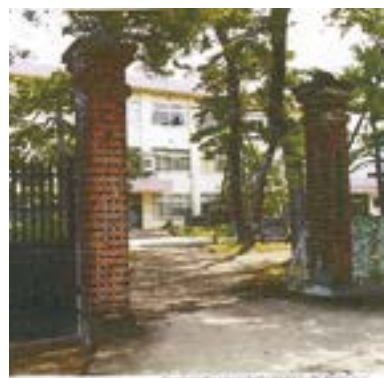
▲村松高校の煉瓦造りの正門は、1903年、新潟県立工業学校時代に建築されたもの。門柱の煉瓦の組積法の大きい方の2本はイギリス積、小さい方の1本がフランス積と、珍しい積み方。登録有形文化財に指定されている。
